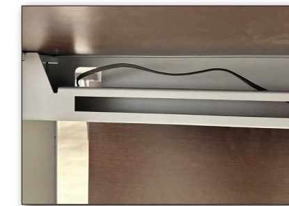
Detalle viga central preparada para la canalización del cableado.
