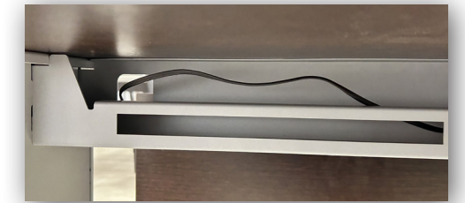
Detalle larguero preparado para la canalización del cableado.
